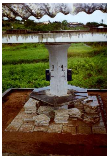
Figura 12: Chafariz eletrônico para distribuição de água em Vertentes/PE
